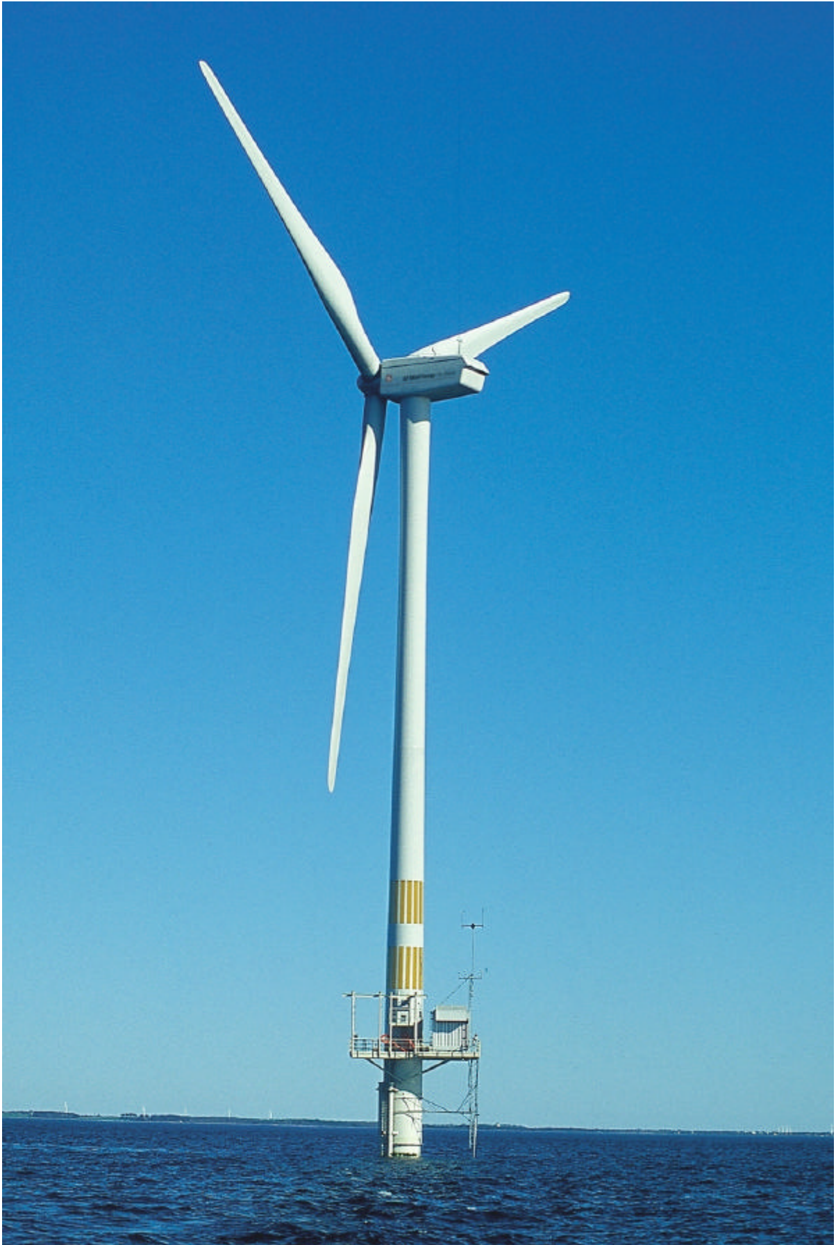
Photo d'une turbine éolienne GE avec fondation monopile
